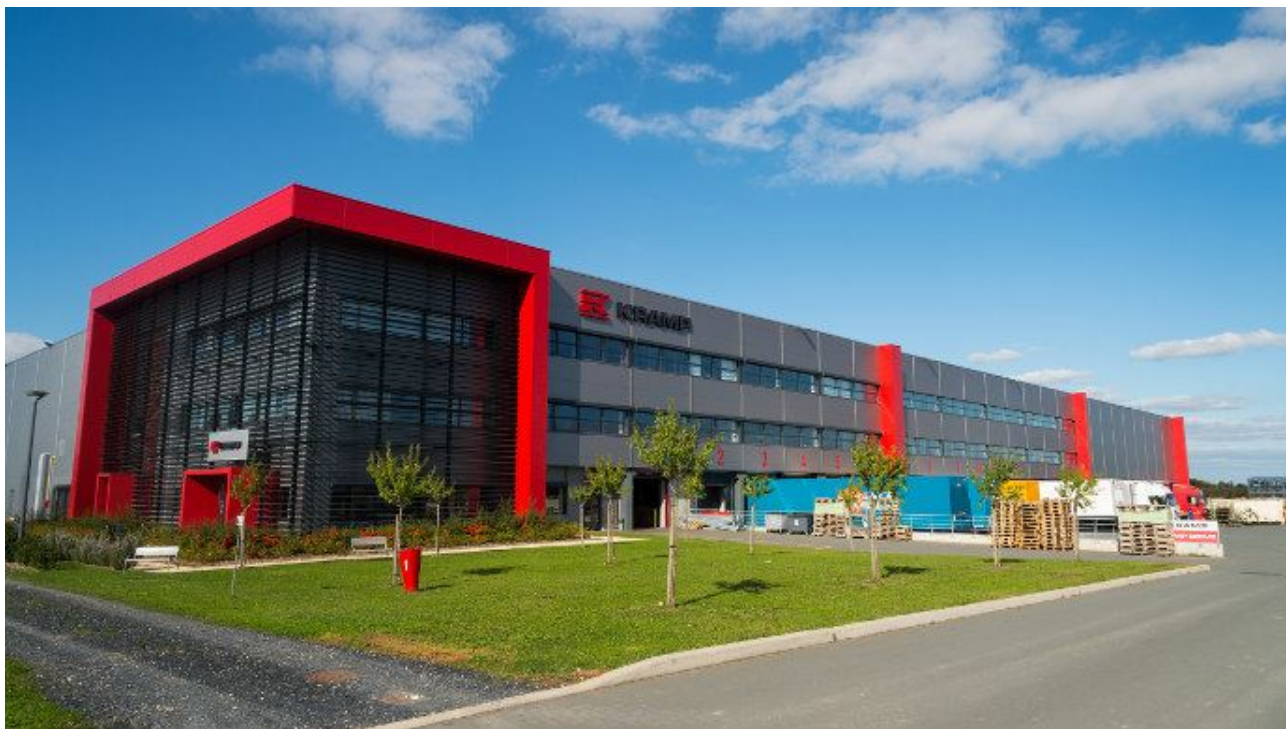
Kramp France : 24 000 m 2 de stockage de pièces de rechange. (@Kramp)
