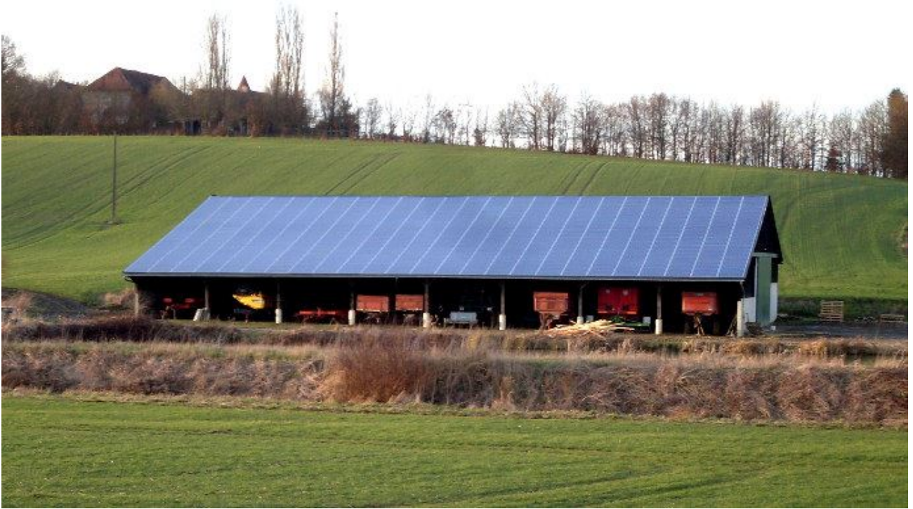
Coudray au Perche (Eure-et-Loir), une installation de 525 panneaux pour une puissance de 91 kW (©Solewa)
