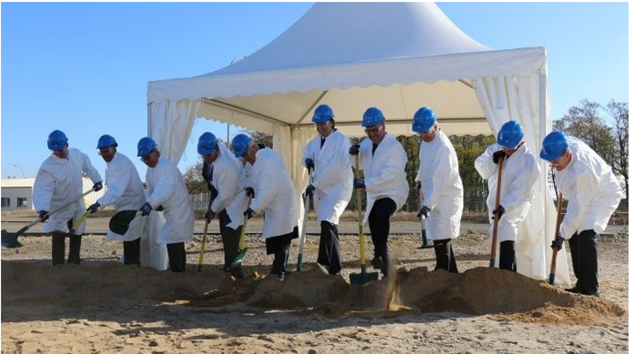
Premier coup de pelle pour la construction de la nouvelle unité de production de l'usine de Corteva Agriscience, située à Cernay (Haut-Rhin). Sont présents sur la photo : Éric Dereudre, directeur Europe du Nord de Corteva Agriscience ; Jean-Philippe Legendre, président de Dow AgroSciences et directeur de Corteva Agriscience ; Patrick Swinnen, directeur de production des sites de Cernay et Uffholtz (Haut-Rhin) ; Rémi Duchêne, directeur environnement, services généraux et relations publiques des sites de Cernay et Uffholtz, ainsi que des élus locaux. (©Terre-net Média)
