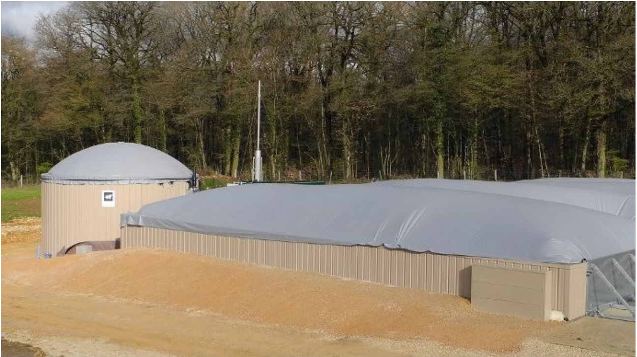
La méthanisation, comme l'ensemble de la valorisation de la biomasse, constitue un potentiel économique important pour le secteur agricole, à condition d'être rentable et rémunératrice. (©EURL Joly)
