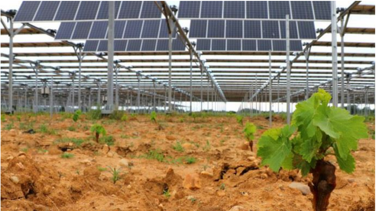
Les panneaux changent automatiquement d'orientation pour assurer le bien-être de la culture et prioriser la récolte. (©Sun'R)
