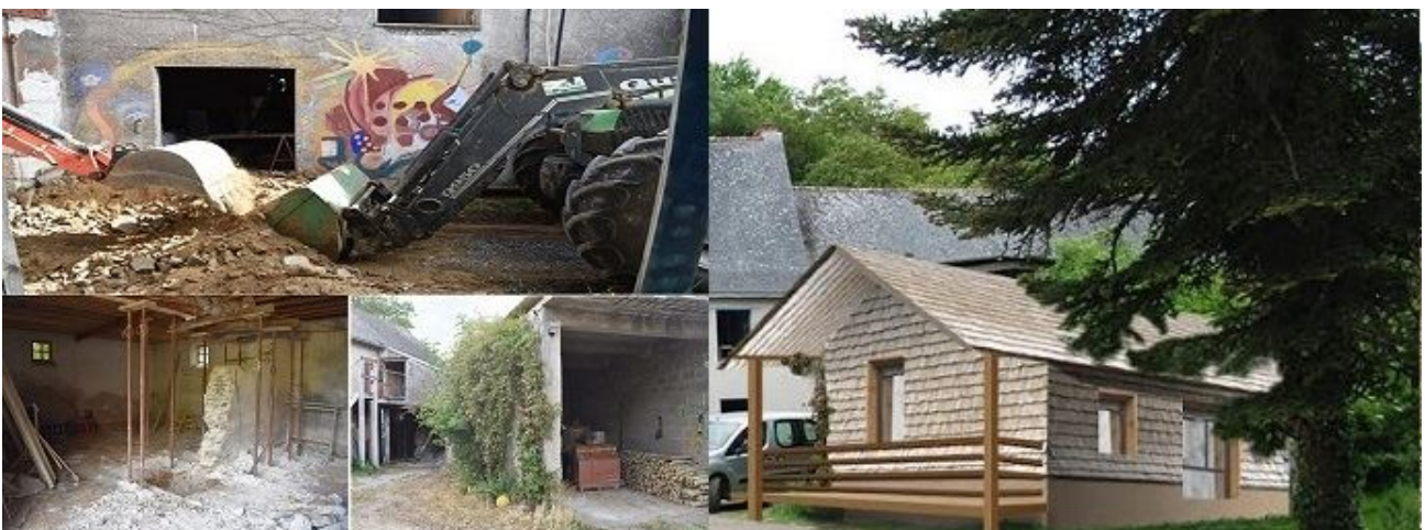
Pour construire le « café-fournil paysan », appelé la Caban'au pain, il a fallu décaisser, couler une dalle béton, monter une charpente, isoler des murs, en poser d'autres... (la photo de droite est un montage, NDLR). (©Franck Perrault)
