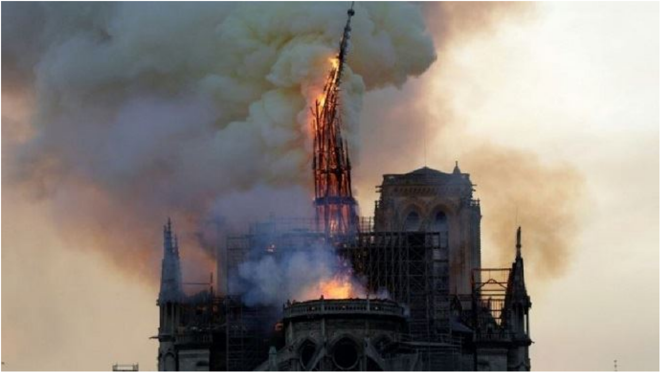
La cathédrale Notre-Dame de Paris en proie aux flammes d'un incendie qui ravagera les deux tiers de sa toiture, lundi 15 avril 2019 dans la soirée. (@@ninoqmr)
